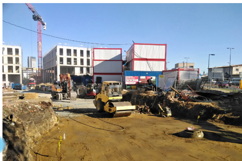
Prace przy skrzyżowaniu ul. Wita Stwosza i Kątowej
