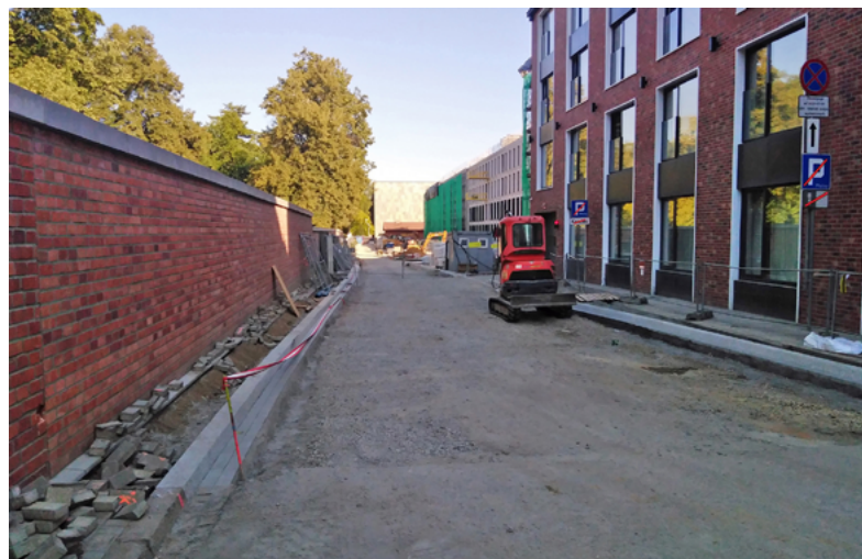
Budowa przedłużenia ul. Żelaznej wzdłuż muru cmentarza Rakowickiego w stronę Archiwum Narodowego
